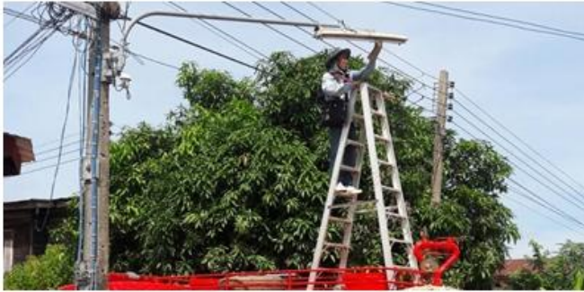
ซ่อมแซมไฟฟ้าส่องสว่างตามคำร้องทั่วไป
